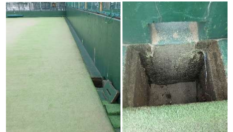
側溝、集水桝まわりの清掃
