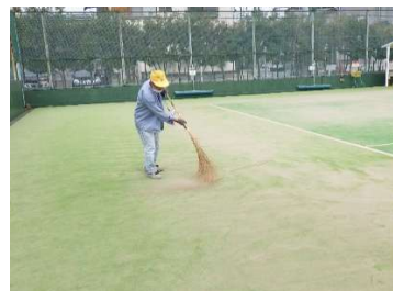
充填砂の均一化作業
