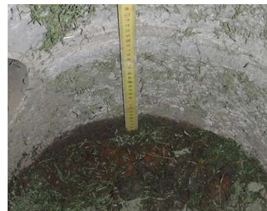
集水枳流入のパイル片と充填材
