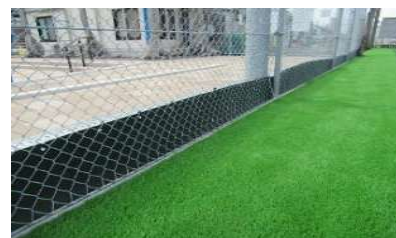
透水ネットの設置 例
