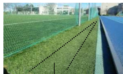
下部は側溝 側溝蓋上部の非充填人工芝被覆 例
