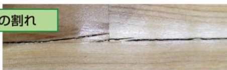
床板の欠損
